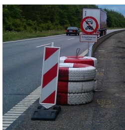
Figur 7.49 Eksempler på dæksøjler som er forsvarligt sammenkoblede.
