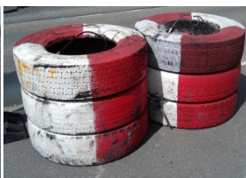
Figur 7.49 Eksempler på dæksøjler som er forsvarligt sammenkoblede.
