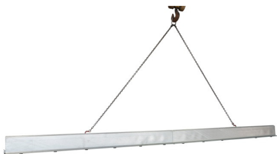
Lyft av förmonterade element
